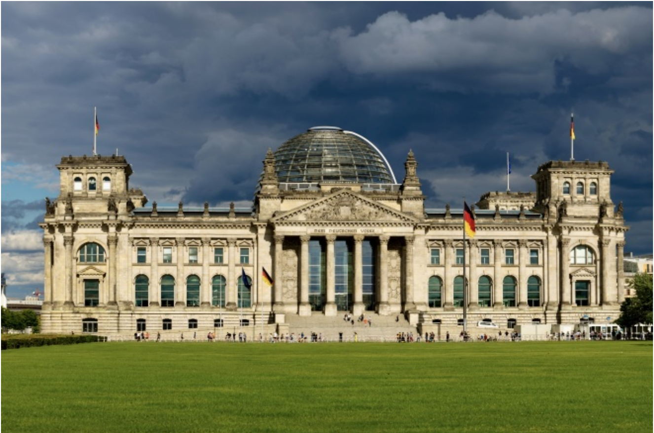
Reichtagsgebäude von Westen
